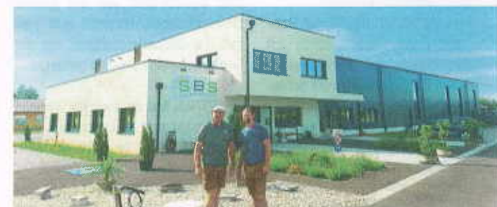
Stöger Bau, Steinakirchen realisierte den Neubau von Social Business Service in Purgstall als Generalunternehmer inklusive Planung und Baumeisterarbeiten. Baumeister Gerold Stöger mit Werner Pitzl vor dem neuen Firmengebäude.
